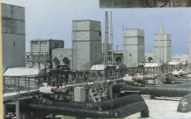
Газокомпрессорная станция с двигателем НК-36СТ.
