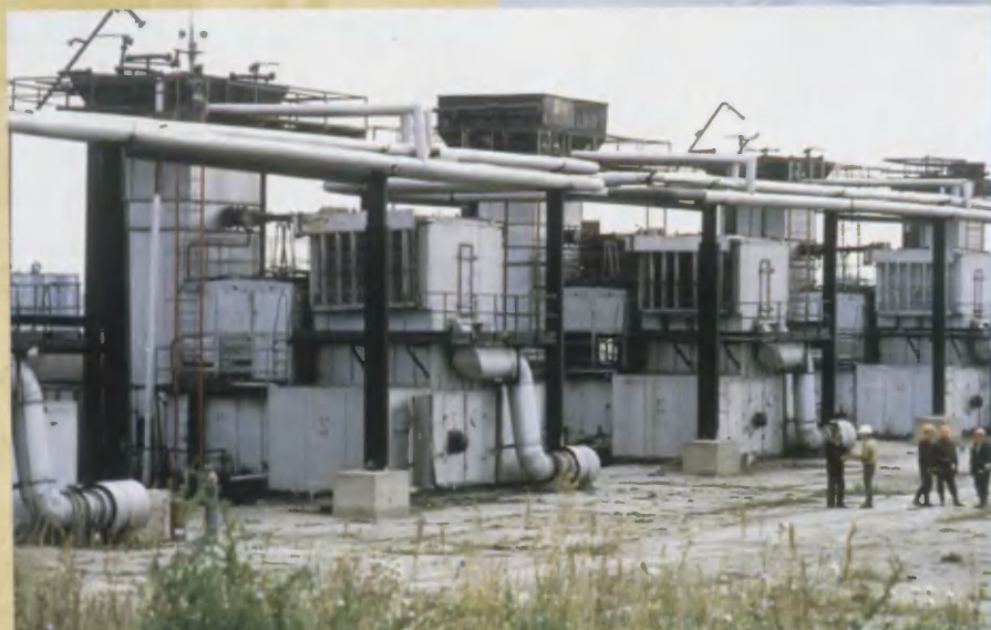
Газоперекачивающая станция. На трубопроводной линии они стоят через каждые 150-200 км. Давление газа за счет такой станции поднимается с 40 до 76 атмосфер.
